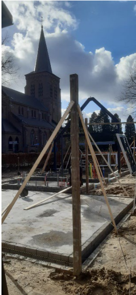
Vessem: de nieuwbouw begint met het gieten van een stevige fundering.
