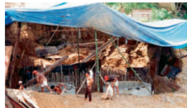
Tumbajae: bouwwerkzaamheden aan een brug.
